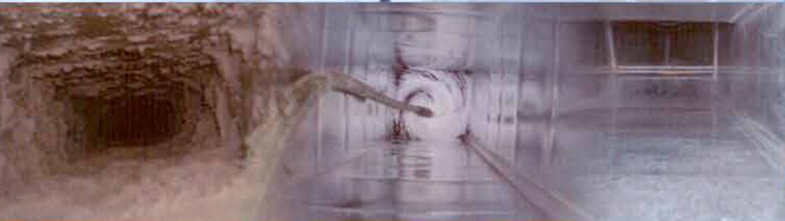
Stato delle condutture prima, durante e dopo la lavorazione
